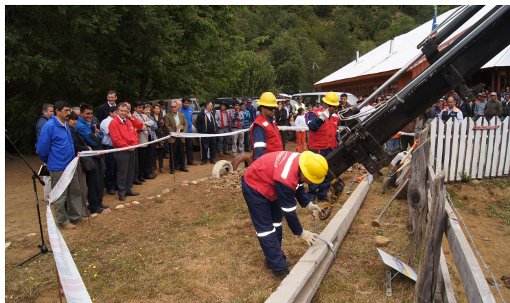
En la Región de la Araucanía autoridades y vecinos participan en la instalación del primer poste del proyecto Llanquén - Contraco en la comuna de Lonquimay.
