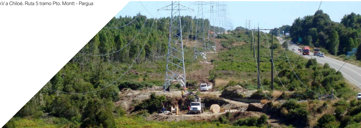
Línea 220kV a Chiloé. Ruta 5 tramo Pto. Montt - Pargua
