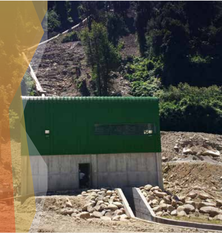
Central hidroeléctrica Las Flores, Futrono
