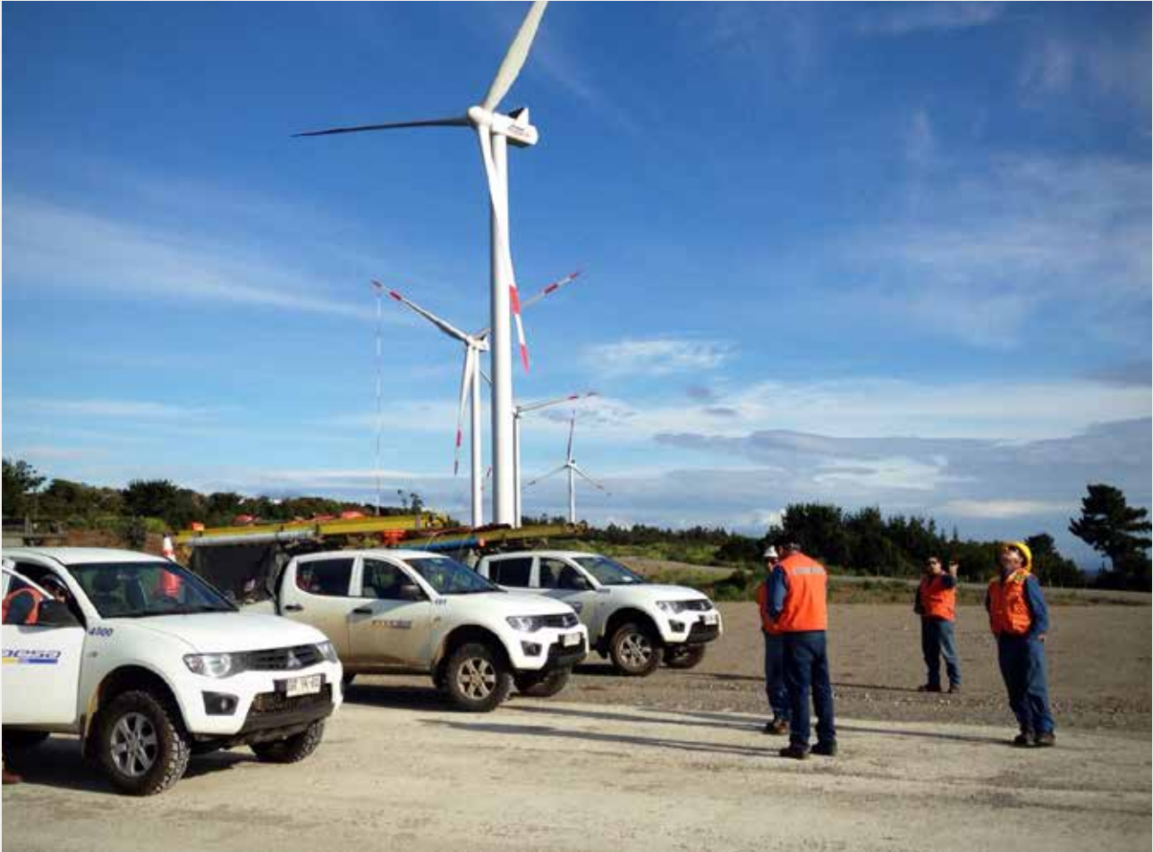
Ampliación proyecto eólico Alto Baguales II.
